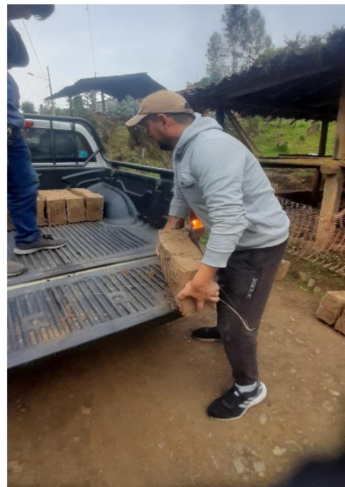
Imagen 42: Transporte de adobes
