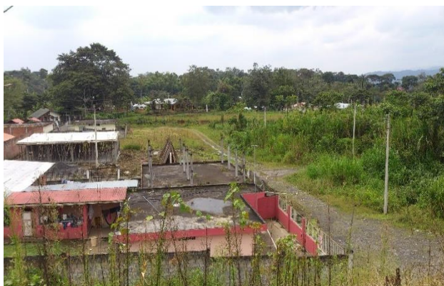
Fig. 6 Irregularidades topográficas del barrio “La Florida II”. Fuente: Autor
