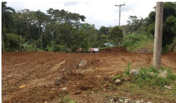
Fig. 19 Vía en construcción. Fuente: Autor
