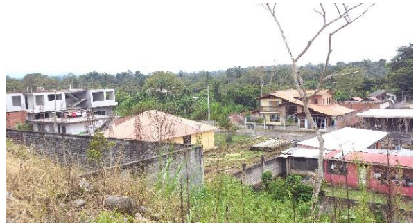
Fig. 16 Viviendas de hormigón Armado. Fuente: Autor
