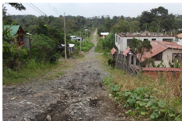
Fig. 5 Irregularidades topográficas del barrio “La Florida II”. Fuente: Autor
