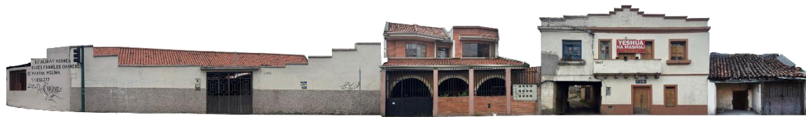
Figura 14: Fotografía de las fachadas del tramo dos, sección tres
