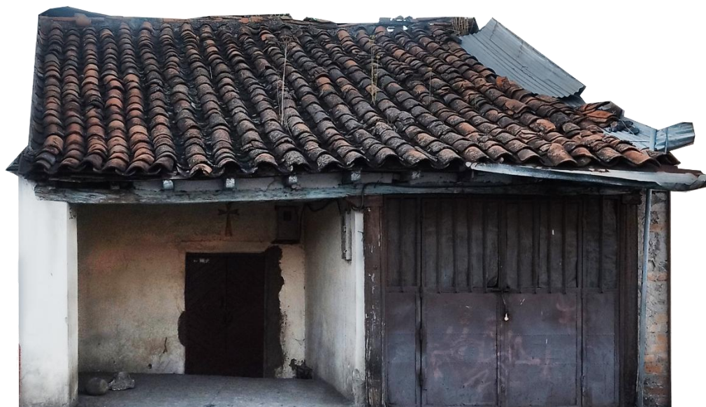
Figura 16: Segunda vivienda de Valor Arquitectónico B
