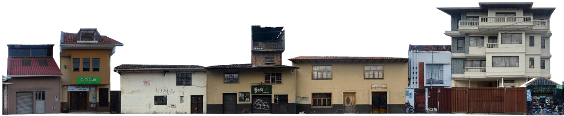
Figura 13: Fotografía de las fachadas del tramo dos, sección dos
