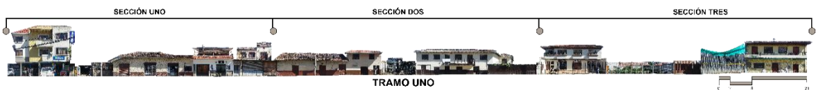
Figura 6: Fotografía de las fachadas del tramo uno y sus secciones
