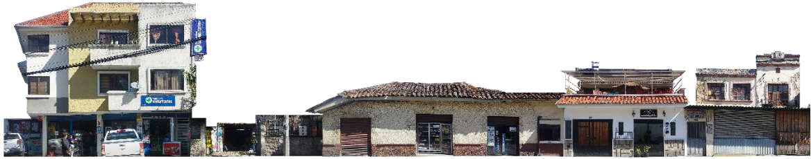
Figura 7: Fotografía de las fachadas del tramo uno, sección uno
