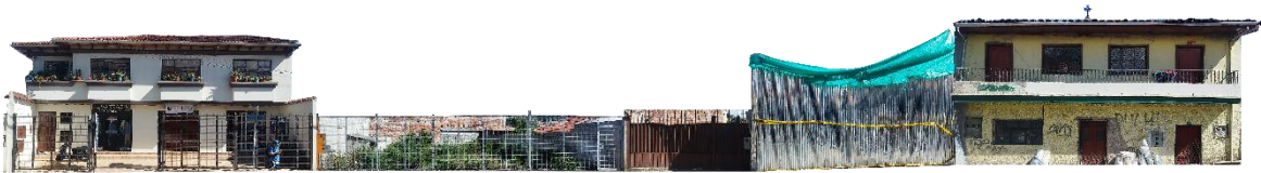
Figura 9: Fotografía de las fachadas del tramo uno, sección tres
