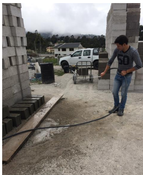
Ilustración N° 10 Proceso de curado de los bloques
