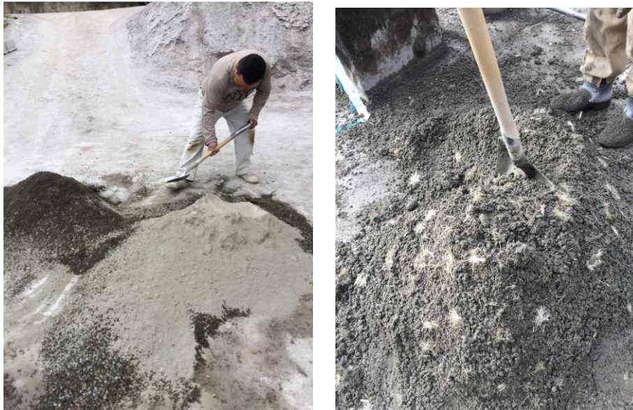
Ilustración N° 6 Preparación de la mezcla y adicción de la fibra de cabuya
