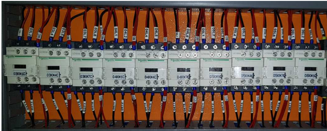
Figura 70. Distribución de los Contactores. Fuente: Induglob.
