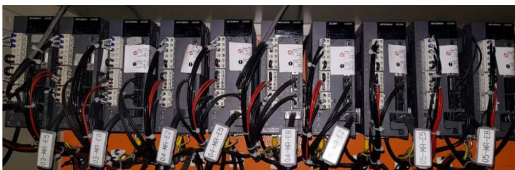
Figura 68. Conexión de los servoamplificadores. Fuente: Induglob.
