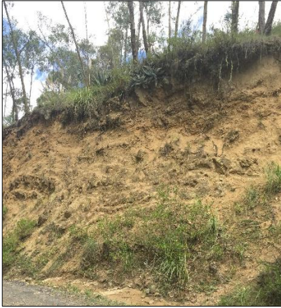
Afección al suelo por movimiento de tierra para ampliación en la vía
