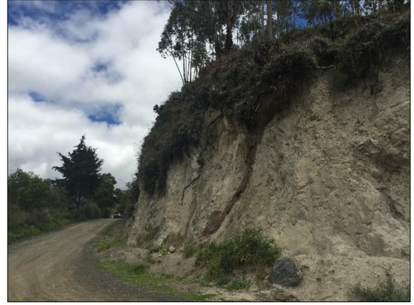
Afección al suelo por movimiento de tierra para ampliación en la vía
