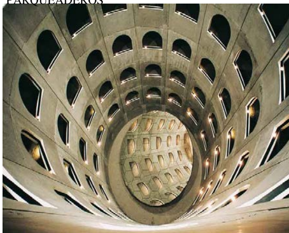
Fotografía N°35 PLAZA CELESTINS- PARQUEADEROS
