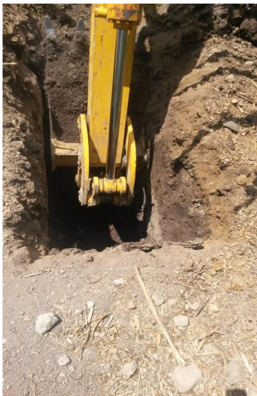
Fotografía 9. Extracción de muestras para Estudio de Suelos.
