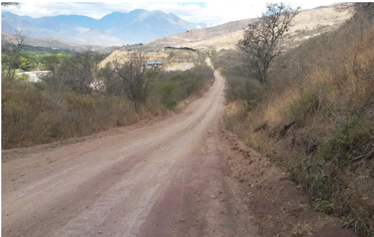
Fotografía 7. Vialidad de la Zona de Estudio.
