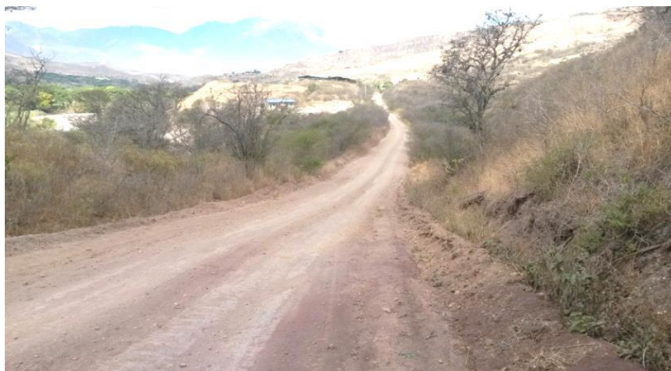
Fotografía 1. Estado actual de las vías del sector de estudio.
