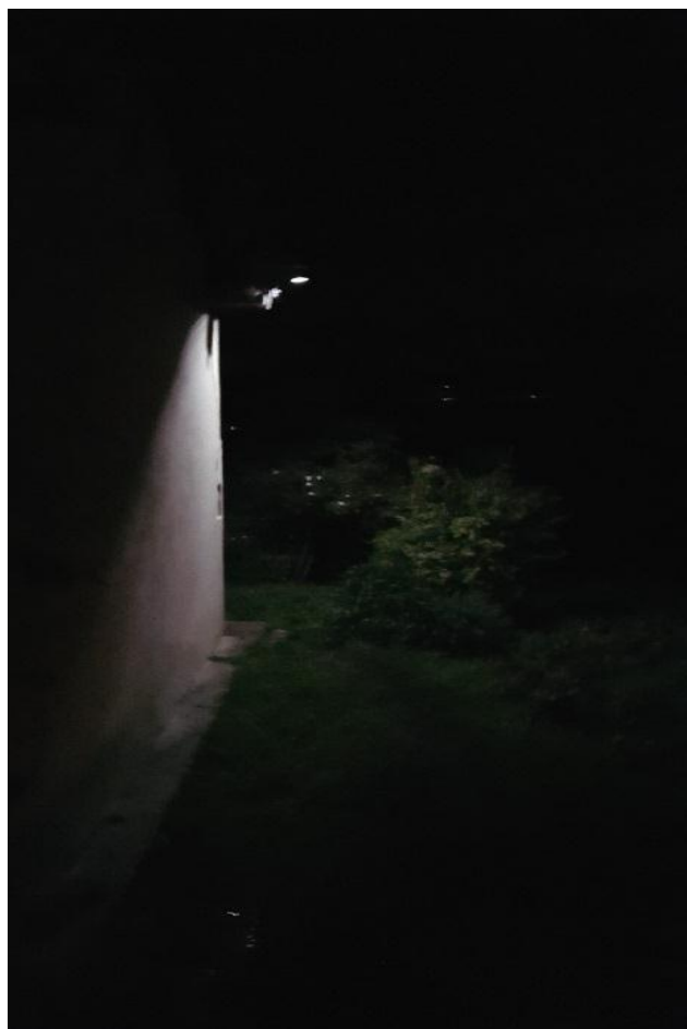
Fig.63 Lámpara fotovoltaica instalada en el acceso a la vivienda.
