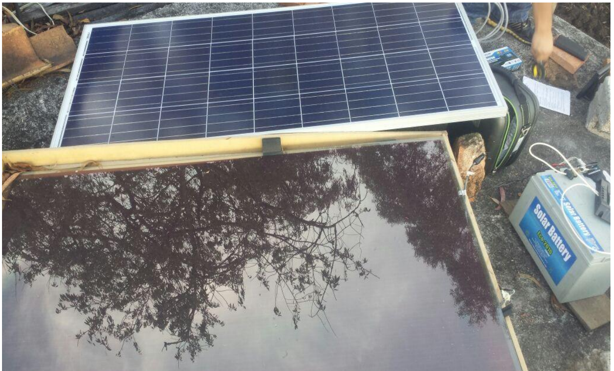
Fig.48 Montaje del sistema fotovoltaico. Fuente: El Autor
