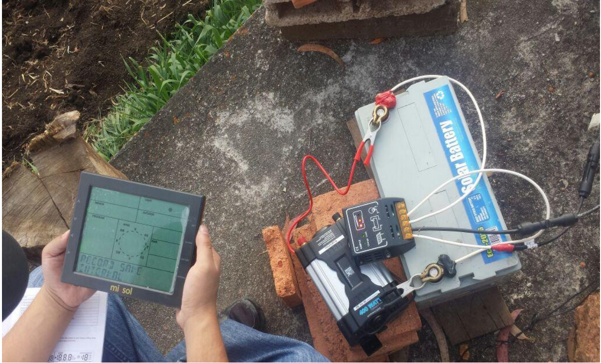
Fig.47 Montaje del sistema fotovoltaico. Fuente: El Autor
