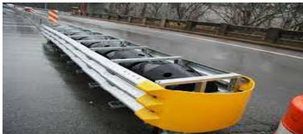
Ilustración 22: Amortiguador sin capacidad de redireccionamiento.
