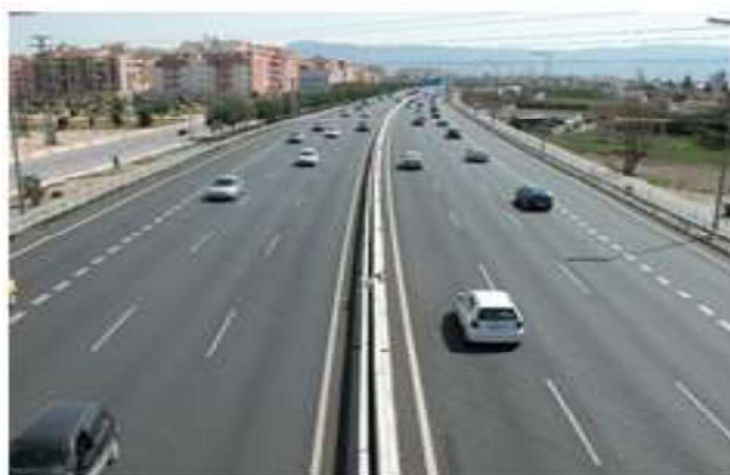
Ilustración 7: Clasificación según el número de calzada.
