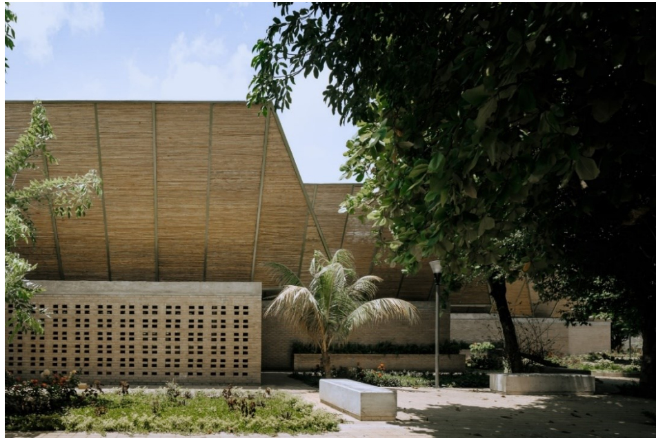
Figura 35: Utilización del bambú y tabique en el mercado Guadalupe
