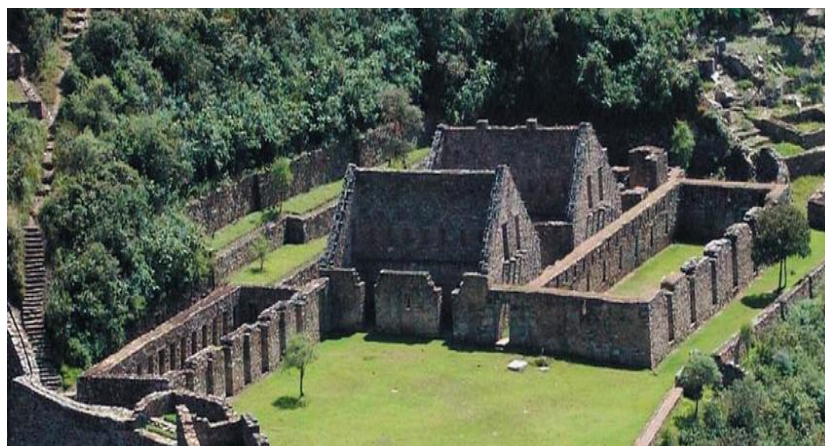
Figura 27: Kallanka inca con vanos trapezoidales, techos a dos aguas y postes internos
