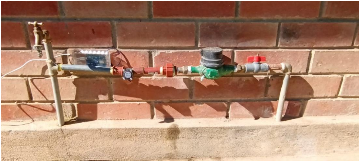
Ilustración 42 Implementación del sensor de flujo y la placa Arduino
