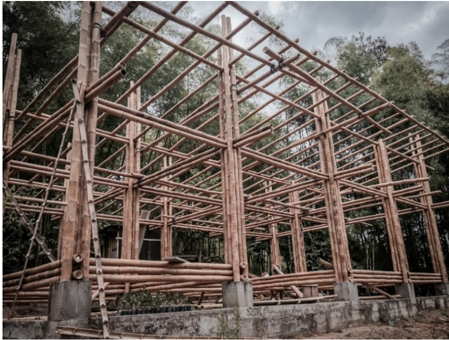
FIGURA 1.32: Estructura de guadúa Casa Convento.
