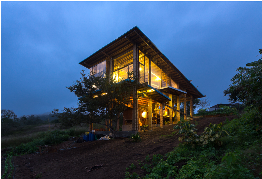
FIGURA 1.41: Fachada Posterior Cabañón DLPM.
