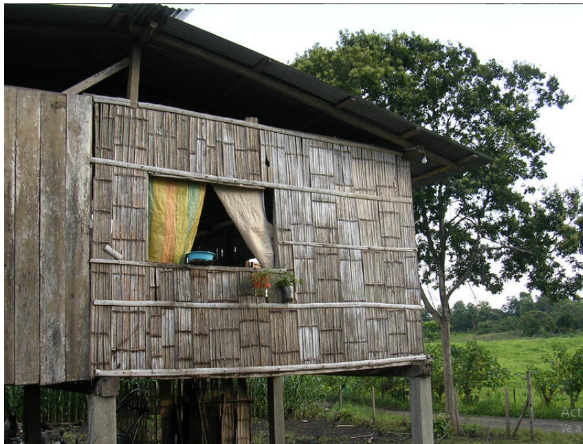
FIGURA 1.1: Casa de caña guadúa.
