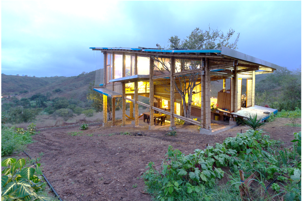
FIGURA 1.42: Fachada frontal Cabañón DLPM - Exterior.
