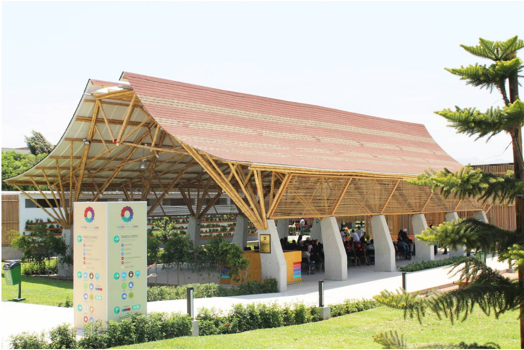
FIGURA 1.18: Cubierta Auditorio de Bambú.
