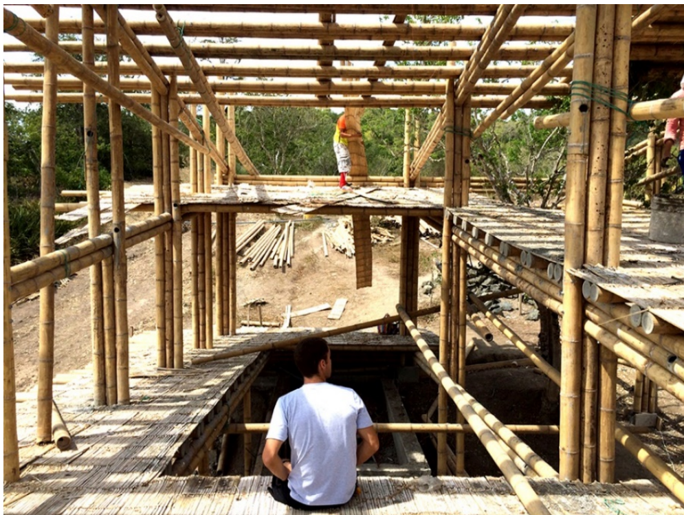
FIGURA 1.39: Estructura Cabañón DLPM.
