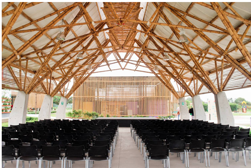
FIGURA 1.17: Estructura vista - Interior Auditorio de bambú.
