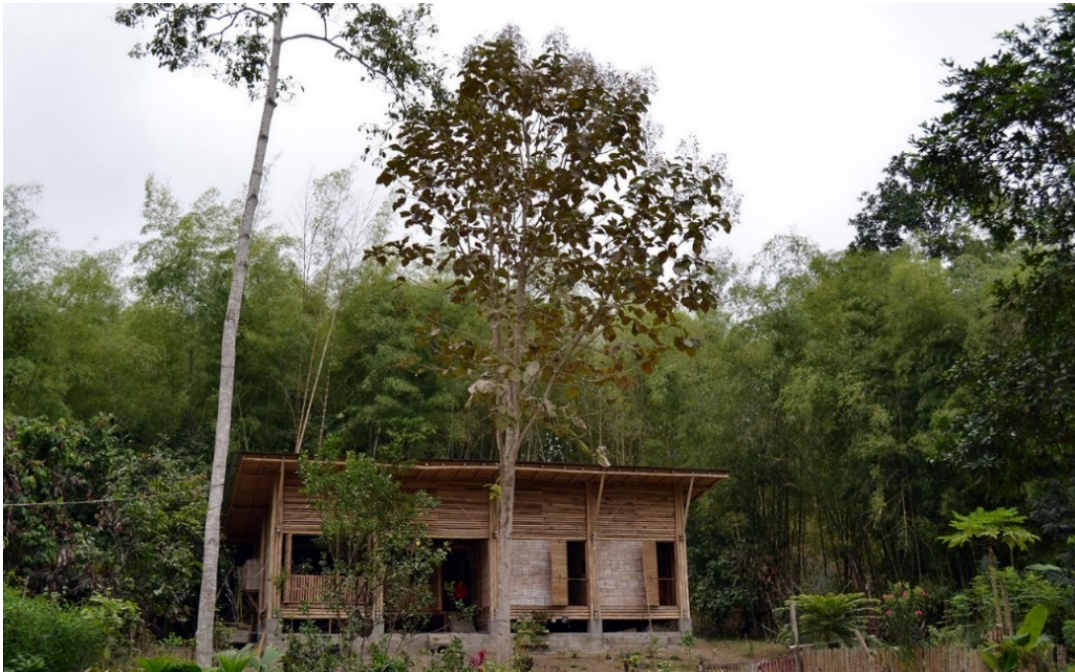
FIGURA 1.31: Casa Convento – Contexto exterior.
