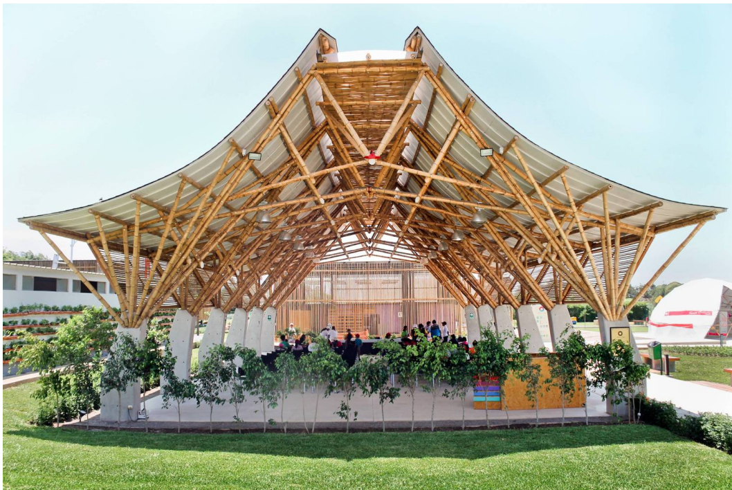
FIGURA 1.19: Auditorio de bambú, fachada frontal.
