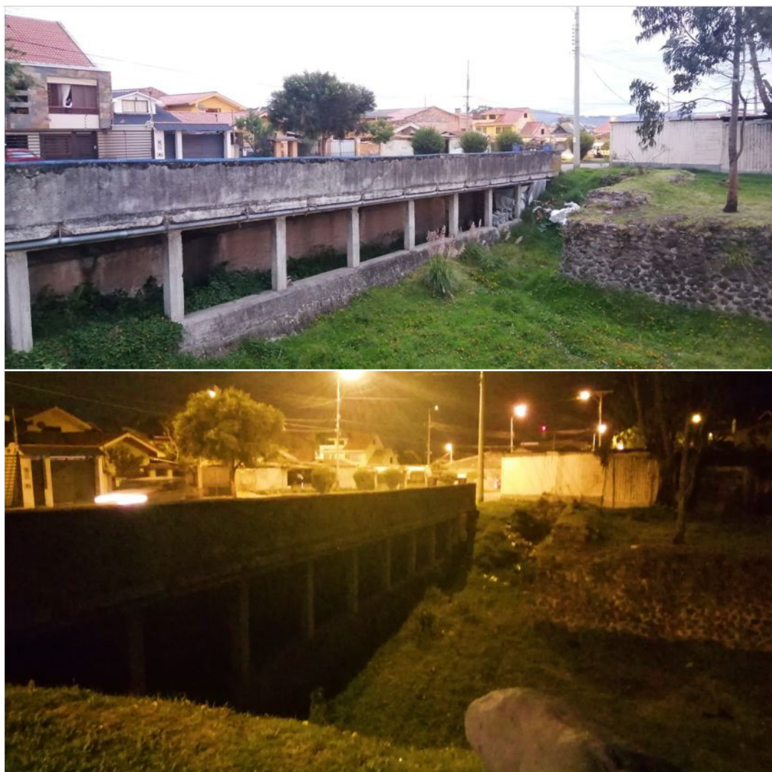
FIG. 1.1: Estado actual del reservorio de agua de la antigua planta eléctrica del río Yanuncay, 2020
