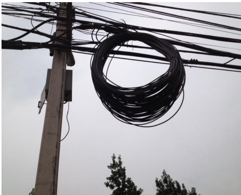
Fig. 6 Acondiciona de fibra en el poste Fuente: (propia)
