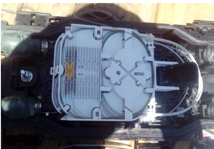
Fig. 53 Correcciones Manga de paso hacia el splitter 1/4 Fuente: (Investigador)
