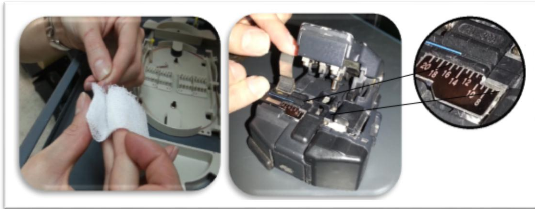
Fig. 72 Limpieza y corte de fibra Fuente: (CONECTRONICA, 2016)
