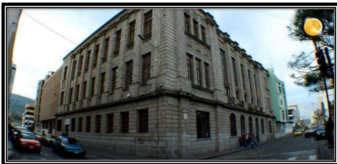
Fig. N° 11 Edificación elaborada con piedra Pishilata
