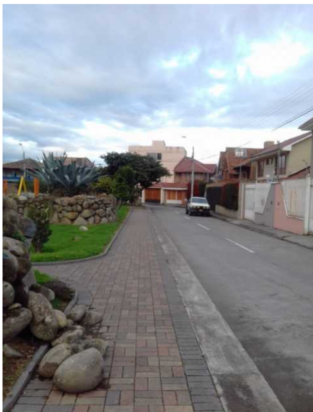
FIGURA 1.2: Derrocamiento de muros de piedra. En primer plano, junto a la calle José Zorrilla. Los muros de piedra presentan mayor facilidad para derrocar y construirse, esto debido al uso único de piedras colocadas una encima de otra. Fuente propia. Carpio, A. Año, 2019.
