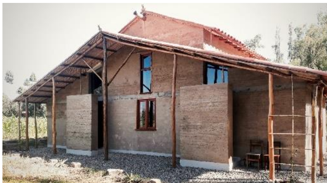
Figura 8. Casa experimental de Tapial.
