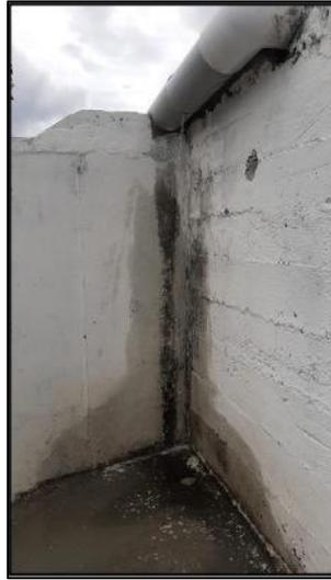
*Nota.* La figura muestra que parte del AR que es transportada a la laguna facultativa, es desviada directamente al tanque de cloración debido a la rotura que presenta. Elaboración propia
