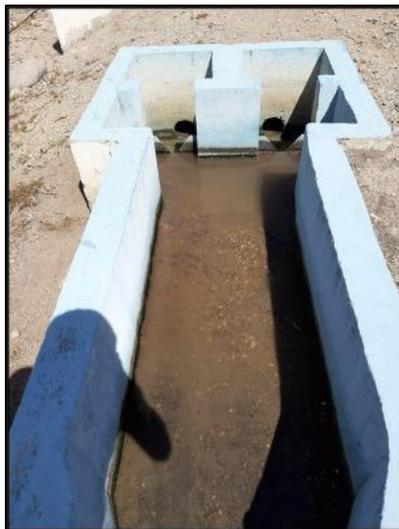
*Nota.* La figura muestra el desarenador suspendido durante el periodo de limpieza. Elaboración propia
