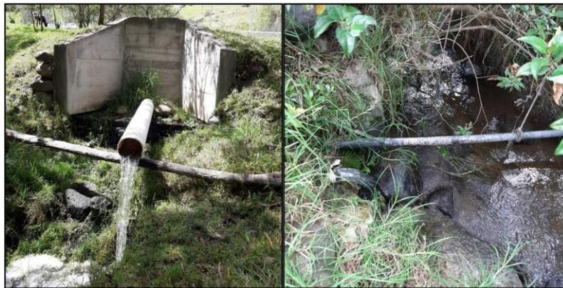
*Nota.* En esta figura se puede observar a la izquierda el efluente de los HHAA que es vertido en el río San Antonio y a la derecha el efluente de los FAFAs que descarga en la quebrada “El Muelle”. Elaboración propia.
