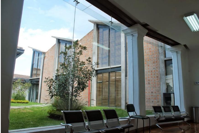
Figura 52: Zona verde como amortiguador del sonido centro ambulatorio de salud mental San Lázaro – Quito.
