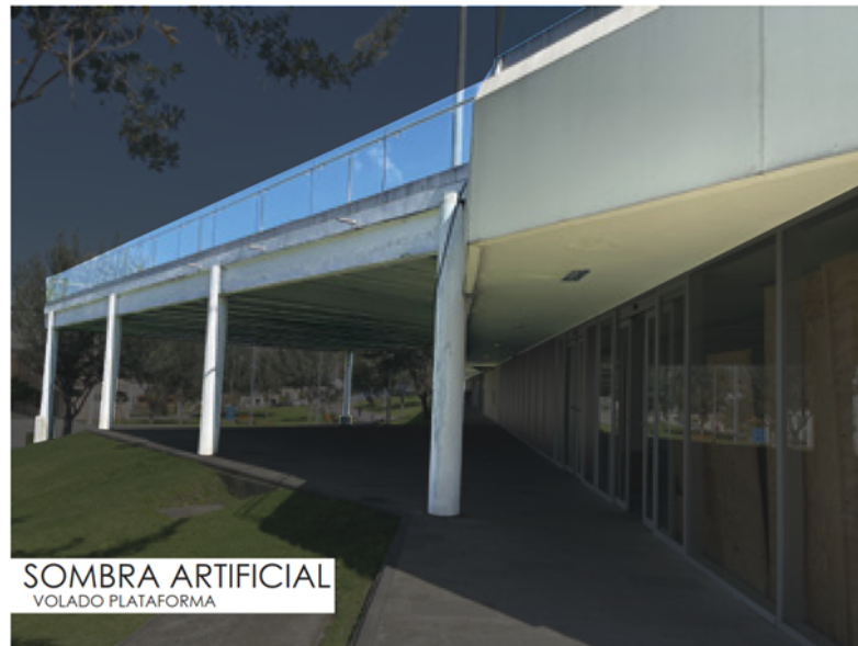
FIGURA 1.39: Sombra artificial de la plataforma en volado. Fuente y elaboración: propia.
