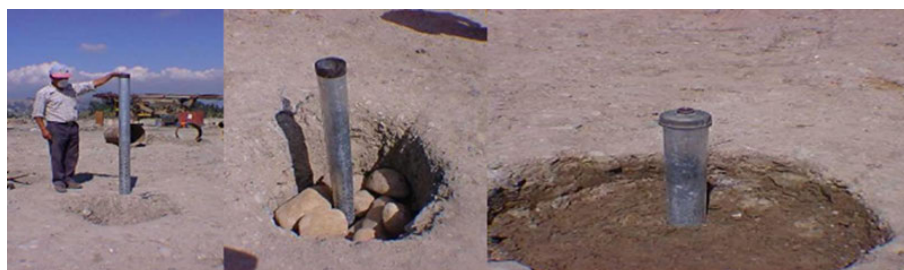
FIGURA 2.5: Chimeneas. Fuente: EMAC, 2015.
