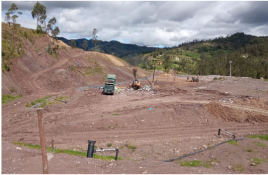
FIGURA 1.13: Complejo de Desarrollo Humano y Ambiental Pichacay. Fuente: https://elmercurio.com.ec/2021/01/23/hasta-2031-operara-relleno-sanitario/
