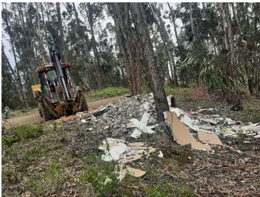
FIGURA 1.12: Escombrera Ucubamba Alto. Fuente: https://twitter.com/emac_ep/status/1346177140572778504
