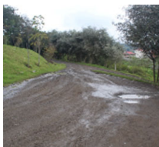
FIGURA 2.52: Acceso planta de compostaje
