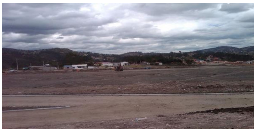
FIGURA 2.8: Cancha en construcción. Fuente: EMAC, 2015.
