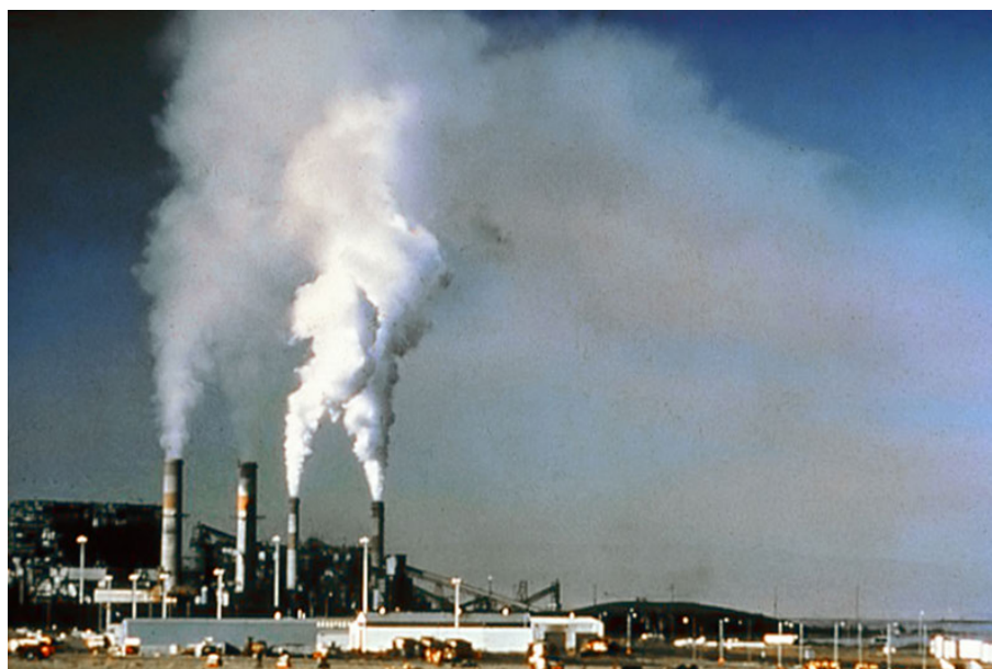
FIGURA 1.15: Planta generadora de Nuevo México. Fuente: https://upload.wikimedia.org/wikipedia/commons/a/a4/Air_pollution_by_industrial_chimneys.jpg
