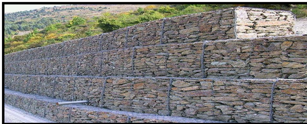
Figura 46: Muro de contención tipo gavión.
