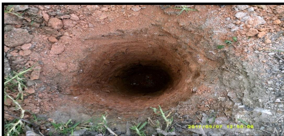
Figura 25: Ensayo de la capacidad soportante del suelo
