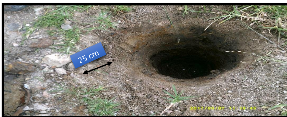
Figura 37: Capa de mejoramiento existente actualmente en la vía Ucholoma.
