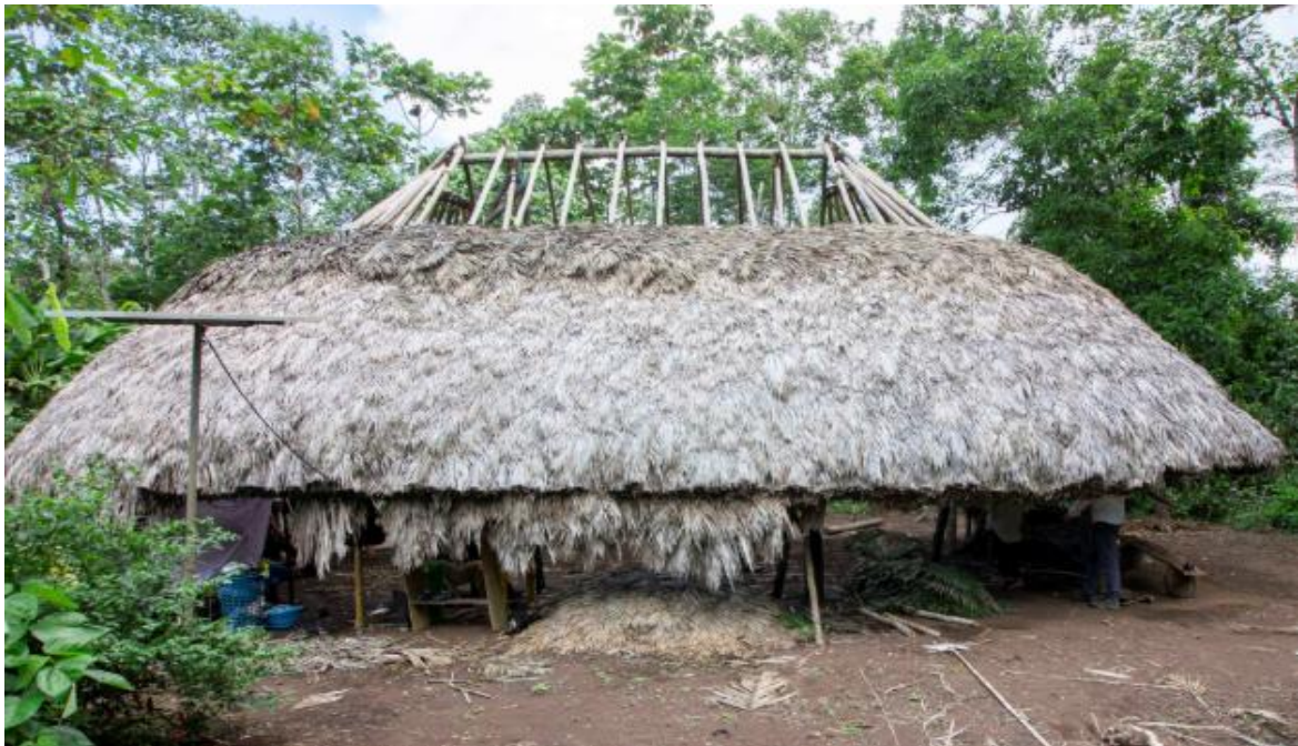
Figura 10: Cubierta vegetal de gran pendiente y borde poroso: lectura de alero bajo, ventilación alta y relación casa–suelo.
