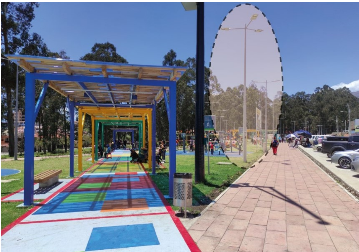
FIGURA 1.40: Luminarias del parque Lineal Yanuncay Fuente: Equipo de trabajo. Elaboración: Equipo de trabajo
