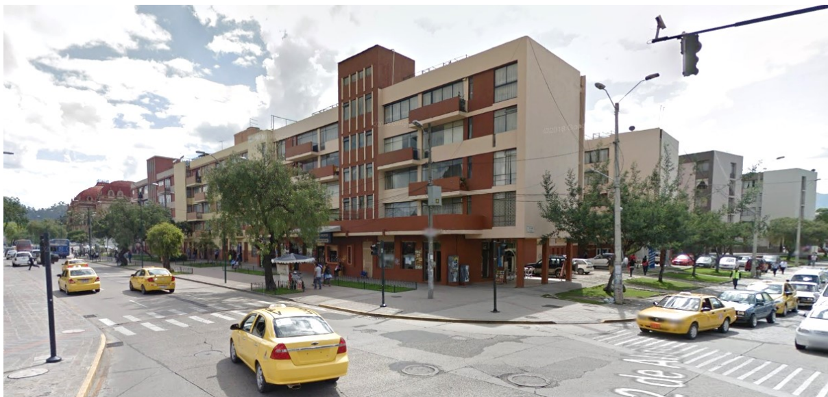
FIGURA 1.1: Multifamiliares del IESS Fuente: Google Maps. Elaboración: Raúl Vizñay
