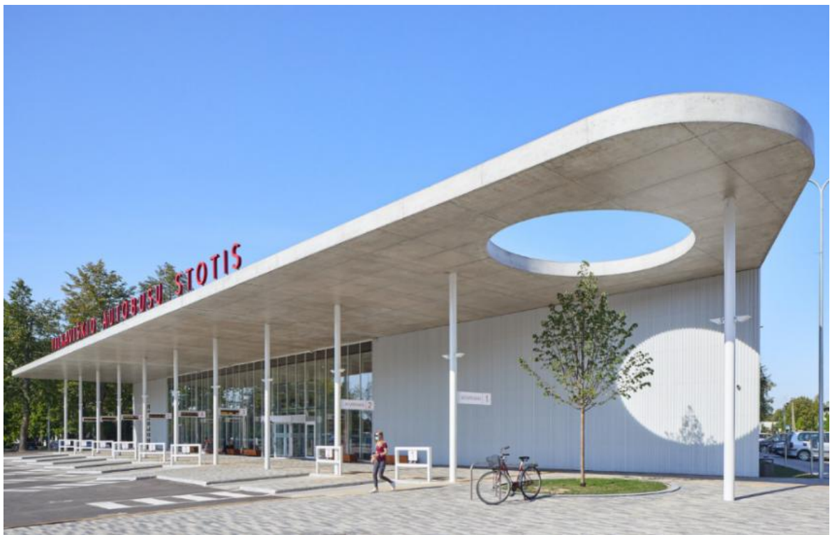
Figura 8: Vilkaiviškis Bus Station
