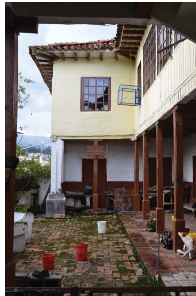
Foto 38: Patio y portal de la Casa - Quinta 02. Fuente: Propia.
