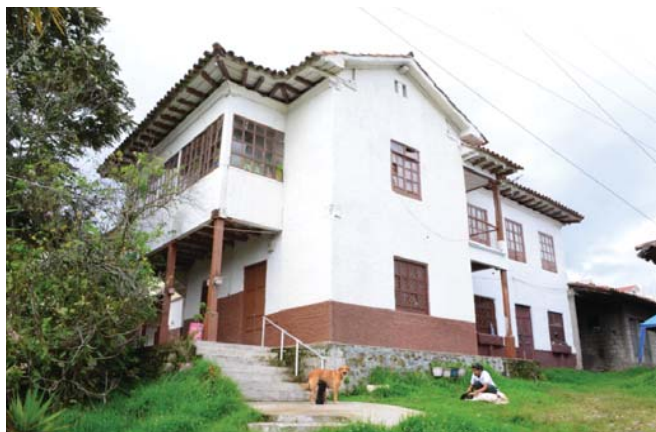
Foto 36: Acceso y jardines de la Casa - Quinta 02. Fuente: Propia.
