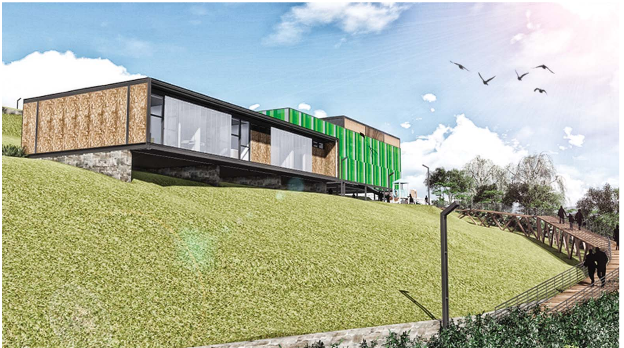
Bloque administrativo CEDISOL ubicado en su contexto
