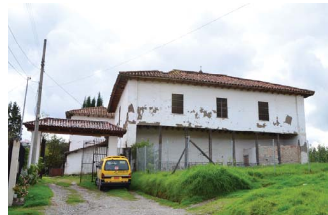
Foto 34: Acceso a Casa - Quinta 01. Fuente: Propia.
