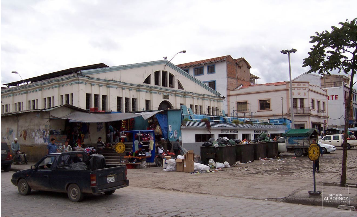
Figura 56: Antes de la rehabilitación Mercado 9 de octubre.
