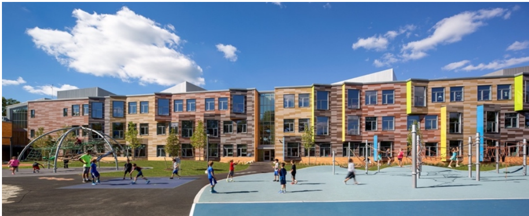
FIGURA 3.14: Zona de recreación Escuela Primaria Woodland. Fuente: ArchDaily México (2018)
