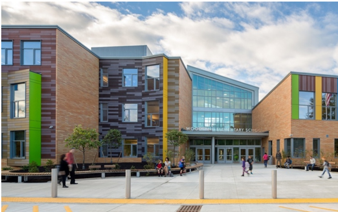
FIGURA 3.11: Escuela Primaria Woodland. Fuente: ArchDaily México (2018)
