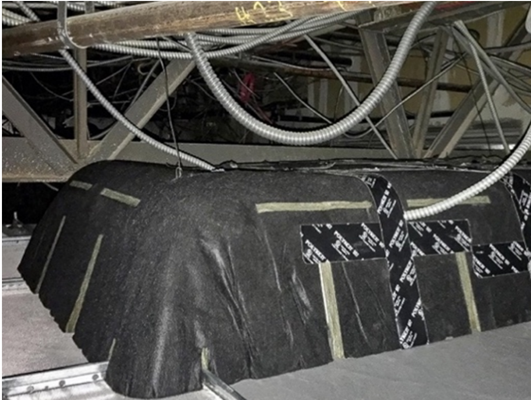
FIGURA 3.7: Barrera de Plafones en la Cubierta De Luz. Fuente: Acoustical Solutions (2017)
