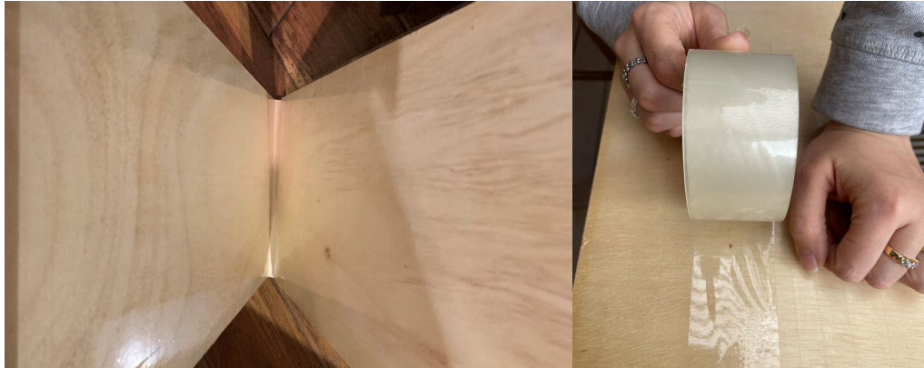
8) Encofrados de madera triplex de 15mm
