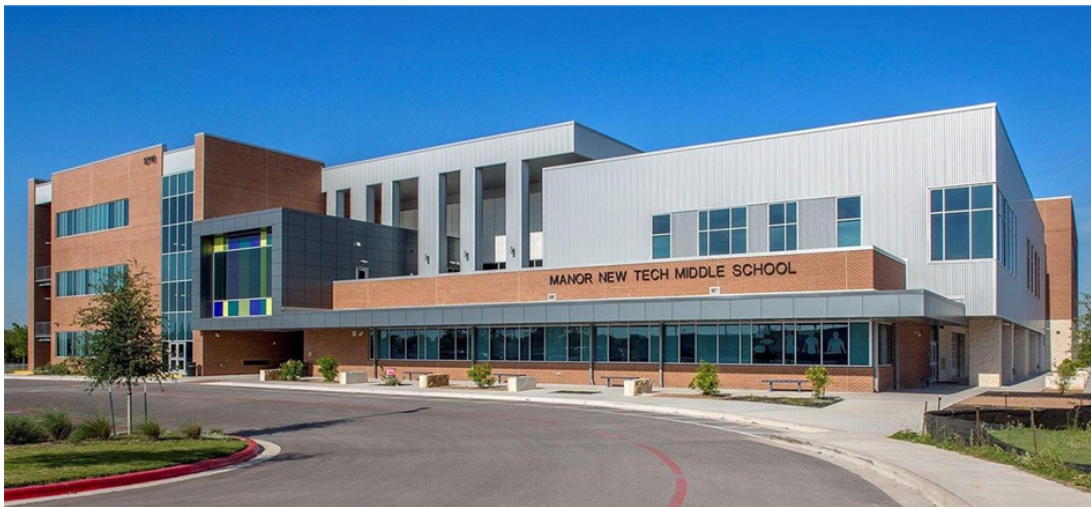
FIGURA 3.20: Escuela Secundaria Manor New Tech. Fuente: VIRCO (2022)
