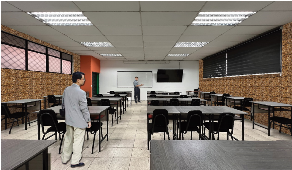
FIGURA 4.37: Salón de clases 210 con panel de aislamiento acústico acabado en tallo de totora (PAAT)
