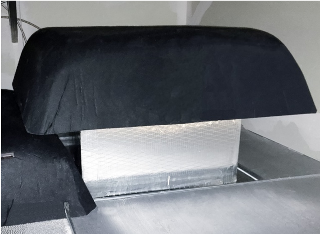
FIGURA 3.8: Silenciador de Retorno del Pleno, la Cubierta de Luz y la Barrera de Tejas de Techo. Fuente: Acoustical Solutions (2017)
