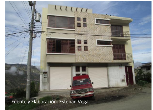
Foto N° 22 Edificación de 3 pisos
