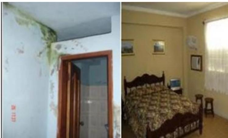
**Figura 18:** Daños de la humedad en una puerta
