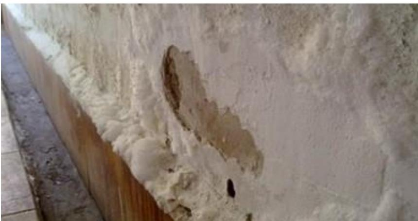
**Figura 4:** Humedad en paredes
