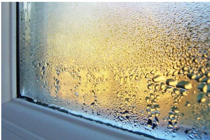
**Figura 1:** Humedad por condensación
