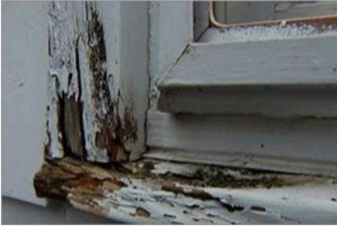
**Figura 19:** Daños de la humedad en una puerta
