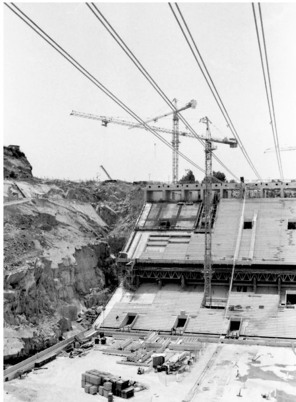
FIGURA 2.19: Proceso constructivo. Fuente: https://revistalibero.com
