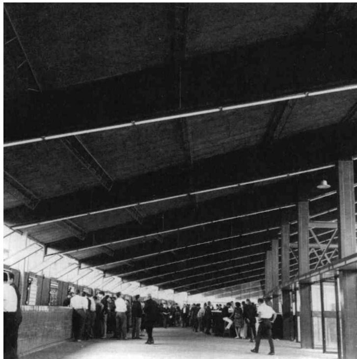
FIGURA 2.32: Zonas internas, estructura vista. Fuente: www.hicarquitectura.com
