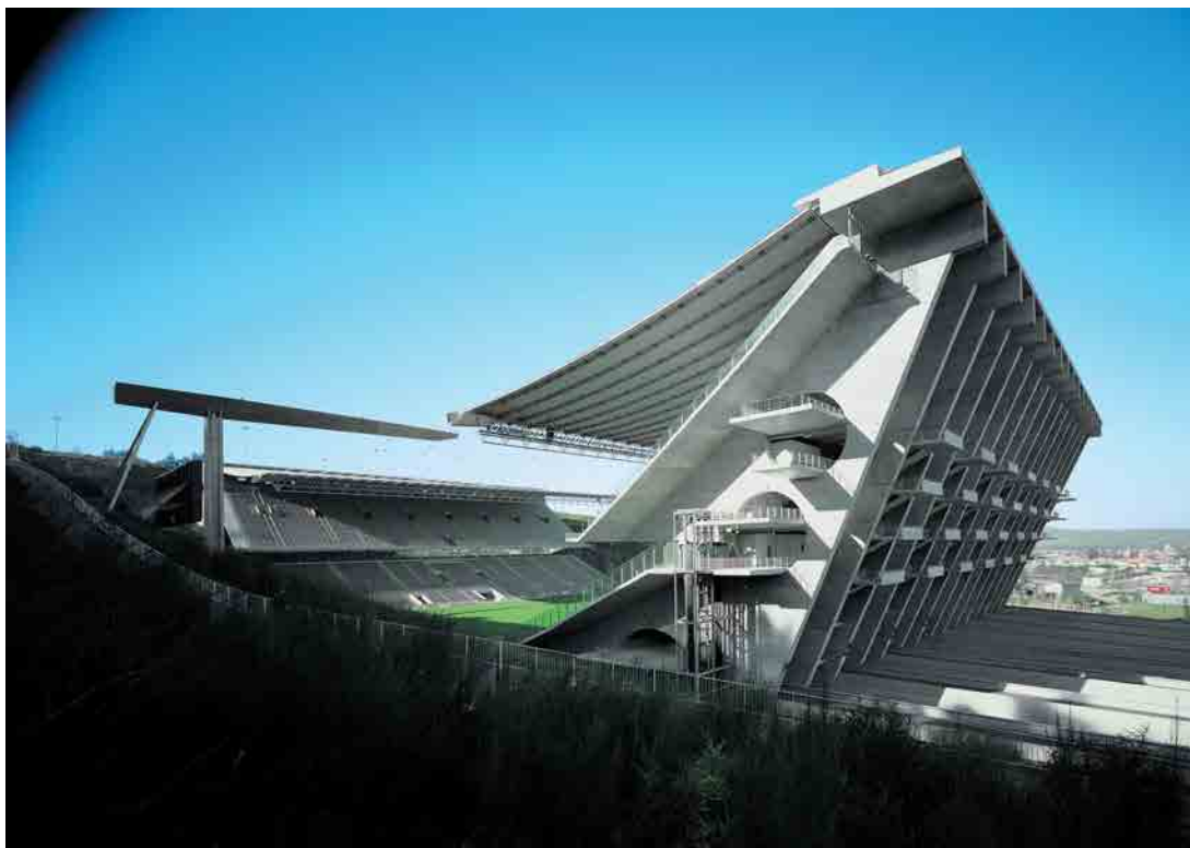
FIGURA 2.12: Zona exterior y sistema de recolección de aguas lluvias. Fuente: www.atlasofplaces.com
