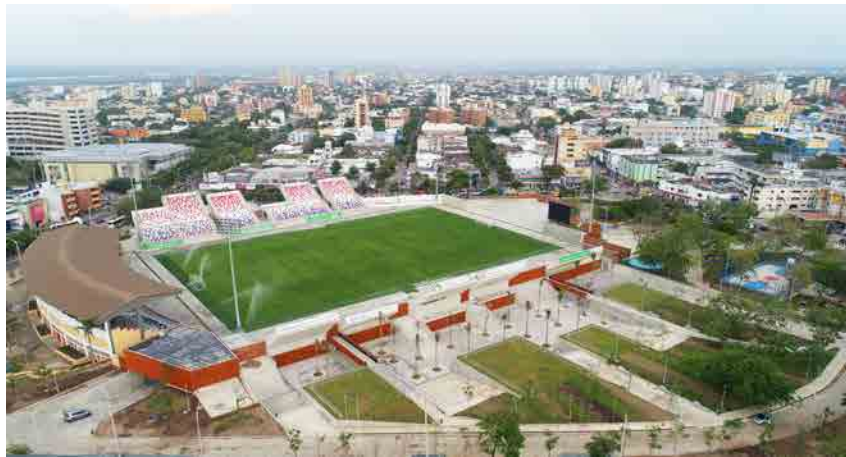
FIGURA 2.58: Contexto Urbano. Fuente: www.plataformaarquitectura.cl
