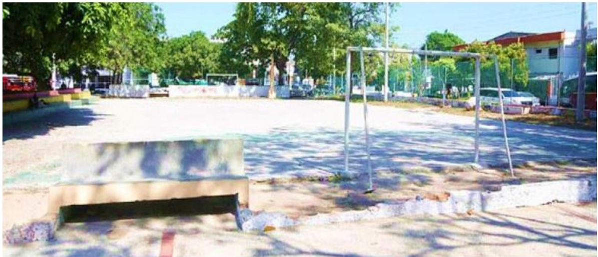
FIGURA 1.12: Cancha de Futbol en diferentes ángulos deteriorada
