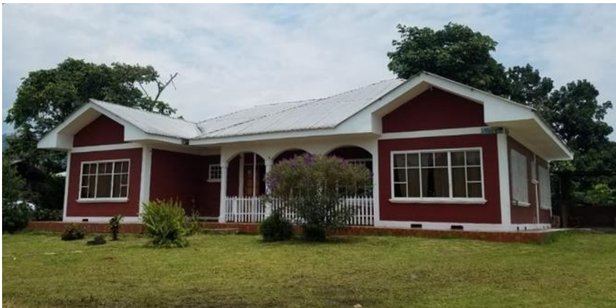
FIGURA 2.10: Tipología de vivienda en la Parroquia Huambi-Departamentos o casa
