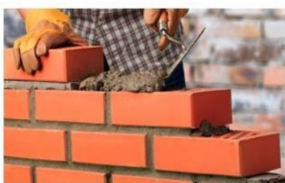
Paredes de Ladrillo visto
