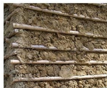
Paredes de caña revestida de bahareque
