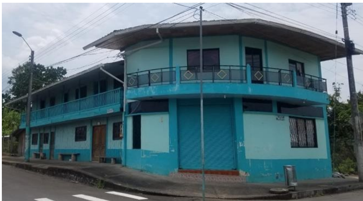
FIGURA 2.11: Tipología de vivienda en la Parroquia Huambi-Cuartos en arriendo Fuente y Elaboración: (Galarza, 2021)
