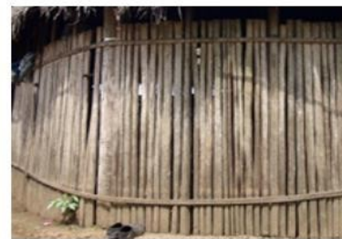
Paredes de caña guadua
