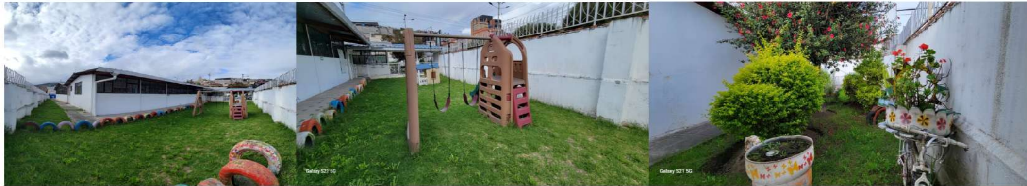
FOTOGRAFÍAS DEL ESTADO ACTUAL, ELEVACIÓN LATERAL IZQUIERDA
