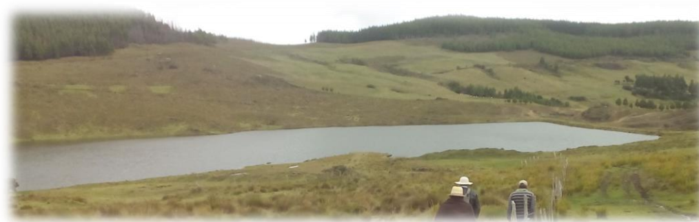
Imagen 18: Reservorio Quinoas durante una inspección. Fotografía: Juan Diego Vélez.
