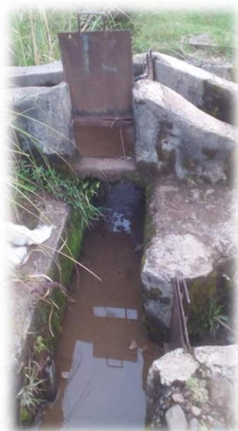
Imagen 9: Estructuras divisoras de caudal compartidas con otra cooperativa.
