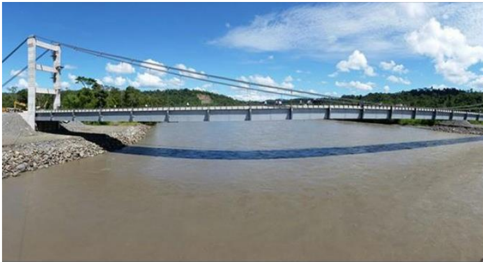
Fig. 9 Viga metálica longitudinal en puente colgante
