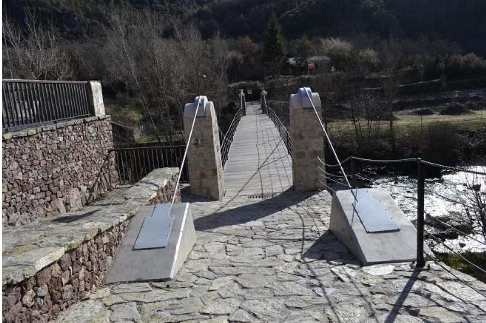
Fig. 14 Anclaje de cables principales en puente colgante
