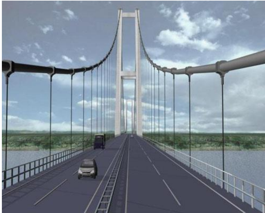
Fig. 11 Cable principal puente colgante
