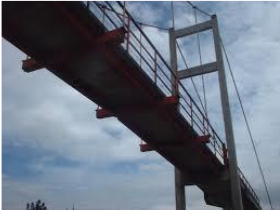
Fig. 8 Viga metálica transversal
