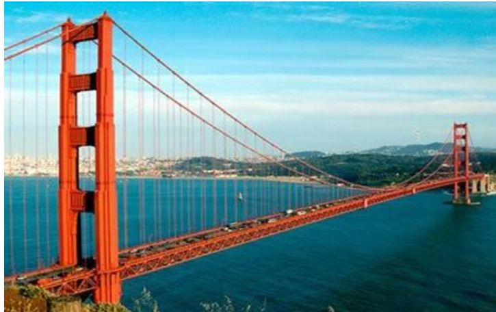
Fig. 12 Torres puente colgante
