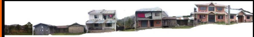
Figura Nº: 99. Vistas al tramo C
