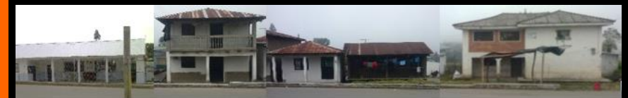
Figura Nº: 100. Vista al tramo D
