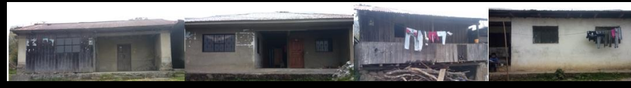
Figura Nº: 98. Vistas al tramo B
