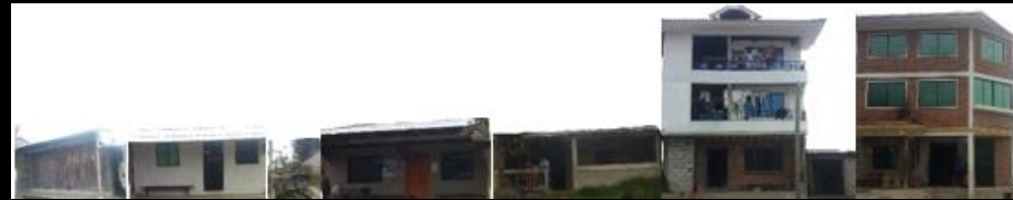
Figura Nº: 96. Vistas al tramo A
