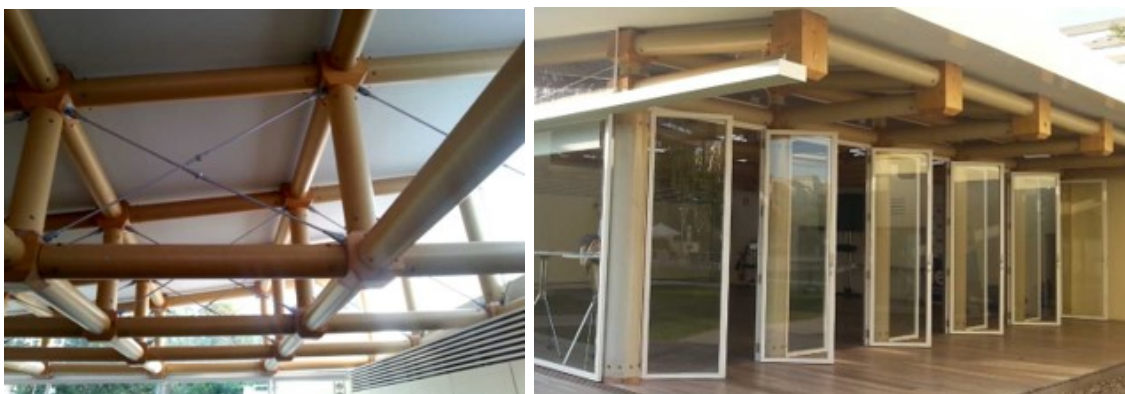
FIGURA 1.22: Cercha de cartón tubular. Tomado de: El Pabellón de estructura de papel de Shigeru Ban, E-STRUCTUR, 2017.
