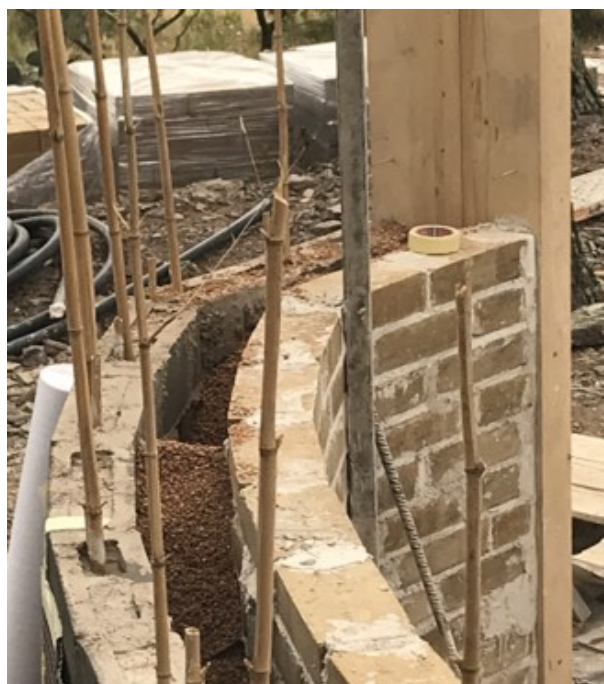
FIGURA 1.17: Usos de los tapones de corcho. Tomado de: los tapones de corcho triturados, una solución constructiva en auge, INSTITUT CATALÁ DEL SURO, 2021.
