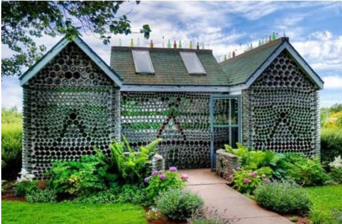
FIGURA 1.12: Vivienda sostenible hecha con botellas recicladas. Tomado de: 6 casas ecológicas con materiales reciclados, INARQUIA, 2022.
