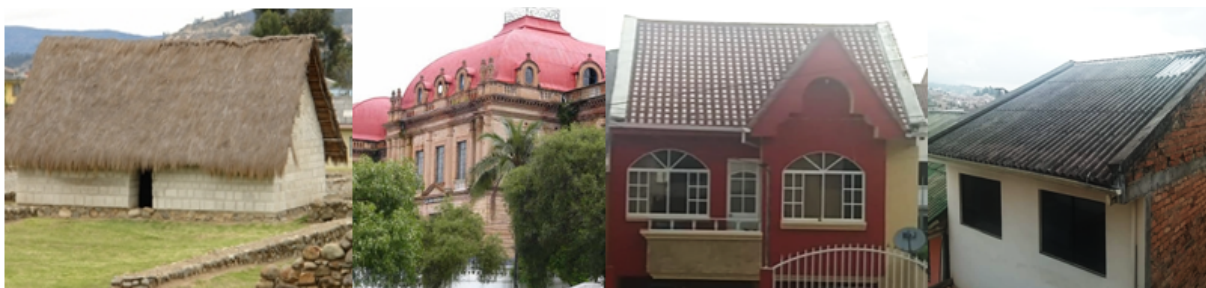
FIG. 1.51: Ejemplos de materialidad de la cubierta en la ciudad de Cuenca. De izquierda a derecha: paja, latón, teja y fibrocemento.
