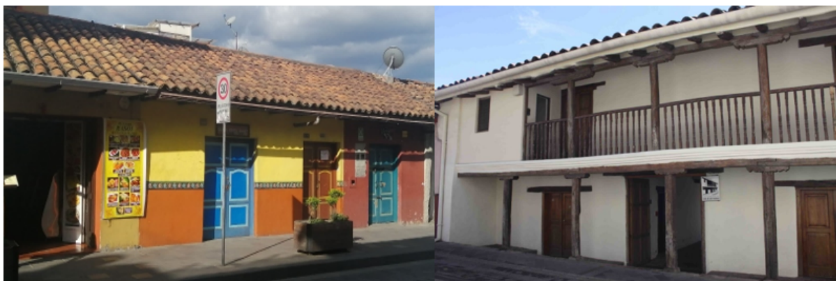
FIG. 1.54: Fachadas exteriores de viviendas coloniales de la ciudad de Cuenca
