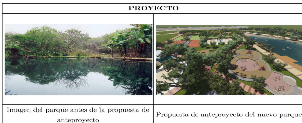
FIGURA 1.32: Descripción del Proyecto. Fuente: Flores (2014). Tesis Parque Ecoturístico, Recreativo, cultural y hotel en el Humedal Abras de Mantequilla, en los Ríos. Elaboración: Propia
