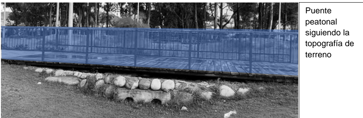
Figura 59: Puente peatonal con estructura de hierro. Elaboración: Ulloa-Villavicencio
