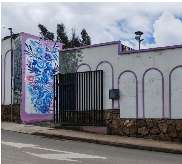
Figura 52: Acceso actual del cementerio.
