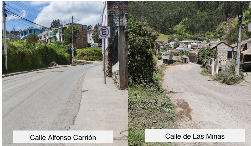
Figura 31: Fotografías del estado actual de las vías.
