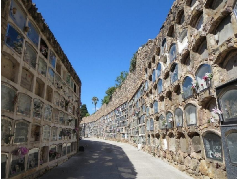
Figura 2: Vista de mausoleos monumentales en el Cementerio de Montjuïc
