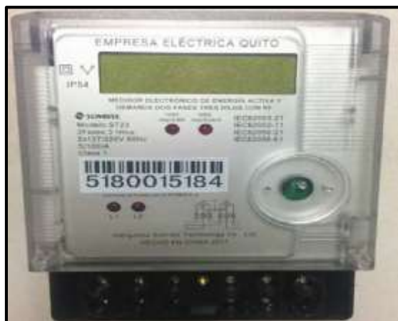
Figura 2 a) medidor bifásico con RF, b) medidor trifásico con RF
