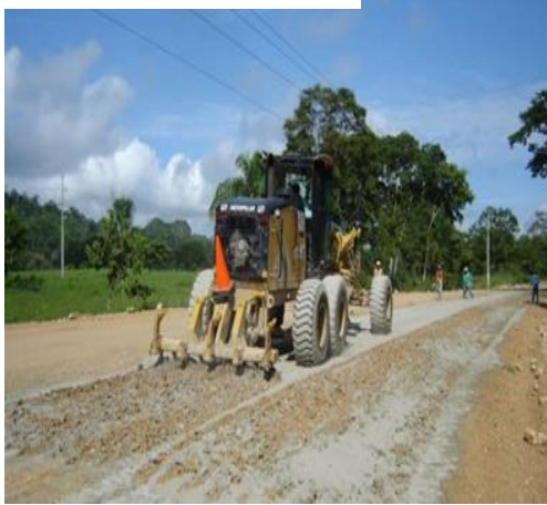
Gráfico 17. ESTABILIZACIÓN CON CEMENTO.
