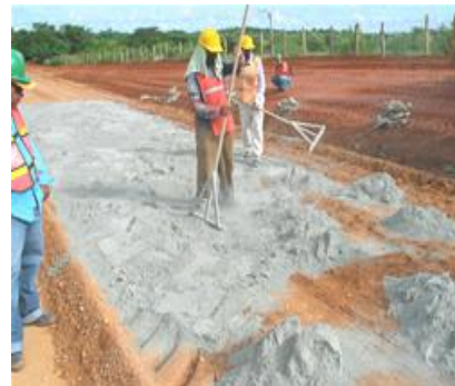
Gráfico 18. ESTABILIZACIÓN CON CLORURO DE SODIO.
