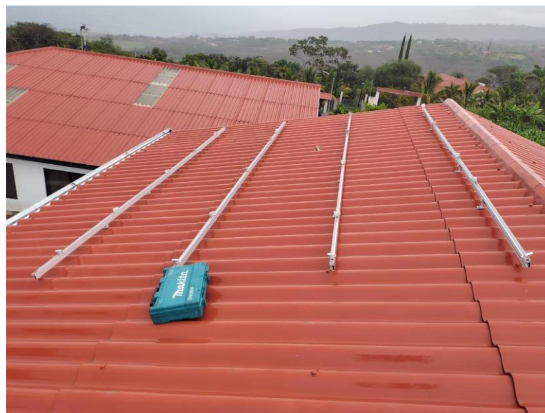
Figura 11. Montaje de estructuras soporte para paneles solares en techo de Eternit sobre estructura metálica
