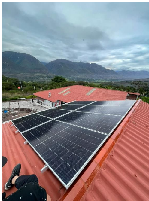
Figura 12. Instalación campo fotovoltaico
