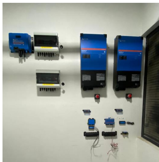
Figura 15. Instalación de Equipos en el cuarto técnico
