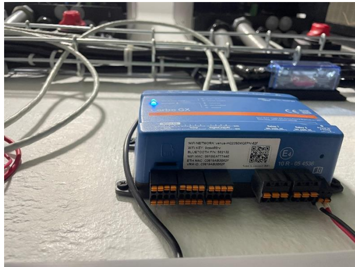
Figura 18. Instalación y conexión sistemas de comunicaciones
