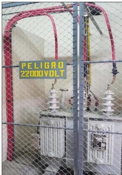
Fig. 22. Alimentación del transformador de 75 kVA.
