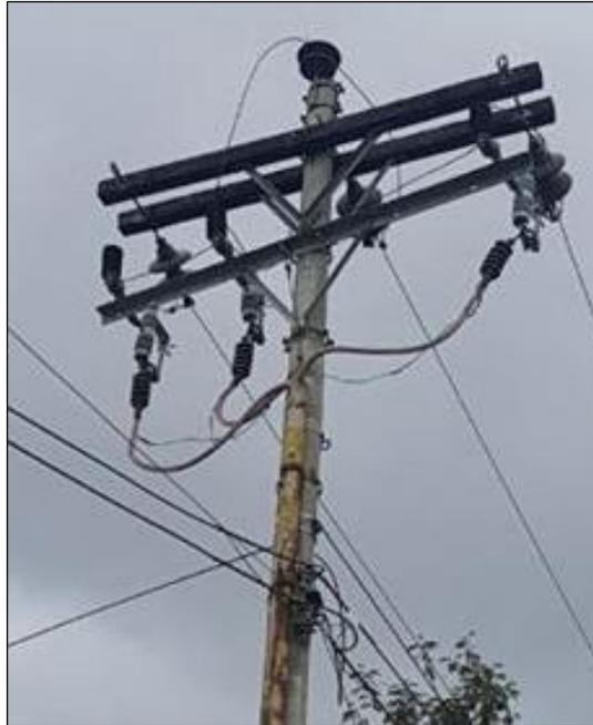
Fig. 21. Red de alimentación hacia los transformadores de 75 kVA y 500 kVA
