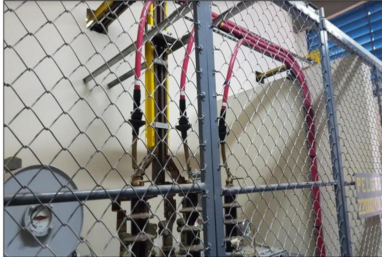
Fig. 23. Alimentación del transformador de 500 kVA.
