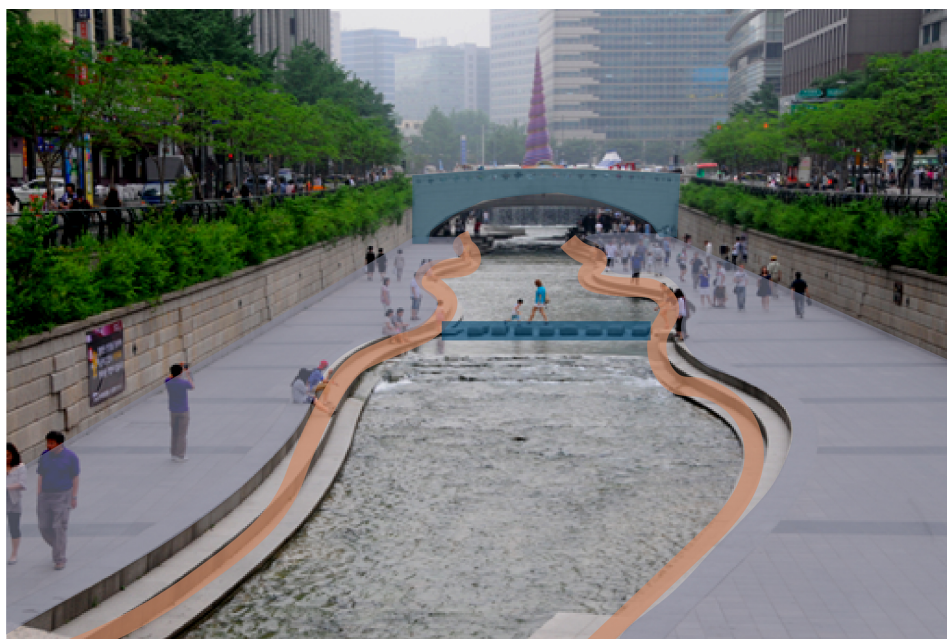
FIGURA 2.12: Nuevo cauce del río Cheong Gye Cheon con los graderíos y conexiones peatonales
