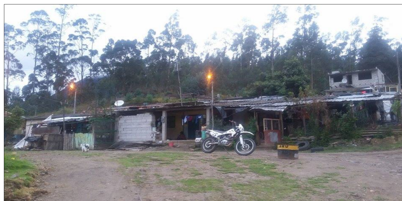
ESTA DO ACTUAL DEL TRAMO 2
