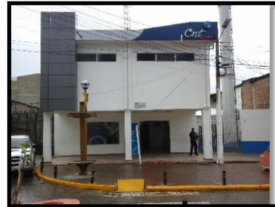
FOTO Nº 21 Edificio del CNT Saraguro
