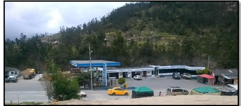
FOTO N° 2 Estación de Servicios Saraguro
