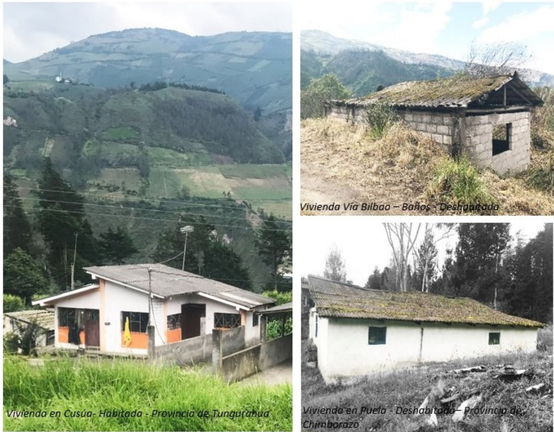
FIGURA 4.9: Viviendas con planchas de fibrocemento
