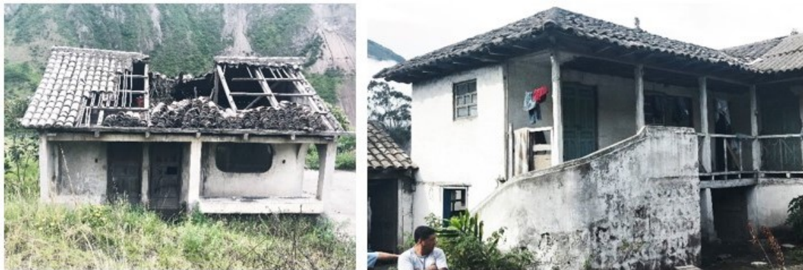
a). Cubierta de teja, fracasada por el peso de la ceniza - Bilbao
