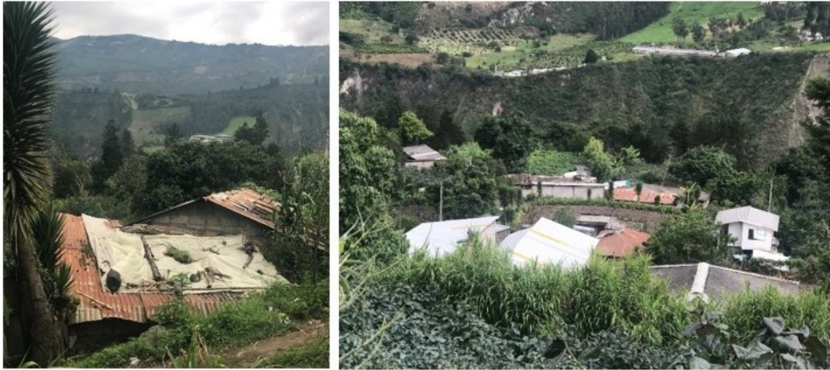
a). Cubiertas de Zinc – Cusúa – Baños de Ambato b). Cubiertas de Zinc – Sector Cusúa - Baños
