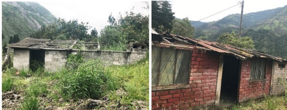
FIGURA 3.22: Vivienda vía Bilbao y Vivienda-Bilbao. Fuente y Elaboración: Propia.
