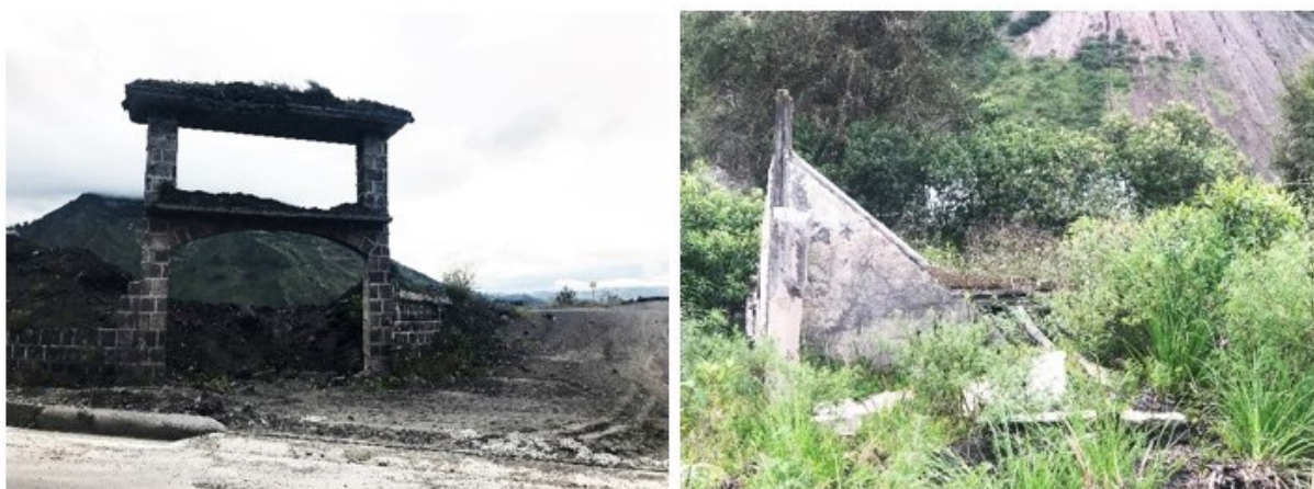
FIGURA 3.18: Restos de hacienda que estuvo ubicada vía a Cusúa y Vivienda ubicada vía a Bilbao.
